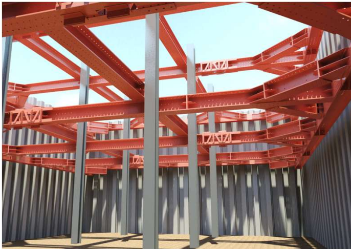
井桁切梁工法
