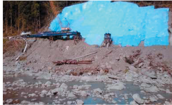
架設工法：手延架設工法 下部工ダウンザホール工法 工期：2011年8月25日～10月10日
