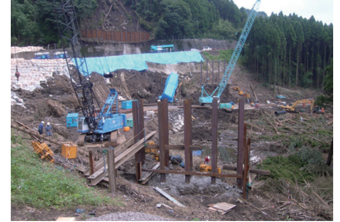
下部工はダウンザホール工法H鋼杭建込にて施工 中間橋脚部は、H鋼杭上にRoRo支柱設置
