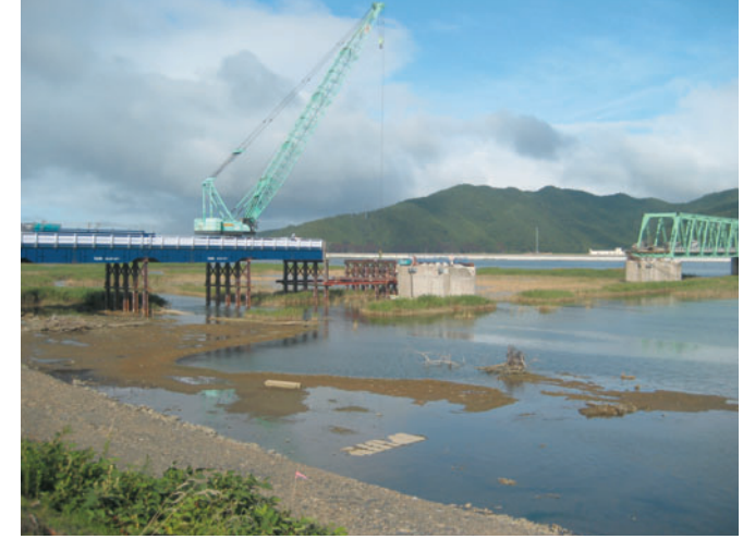
G栈橋工法にて下部工支持杭本数を削減手延にて架設
