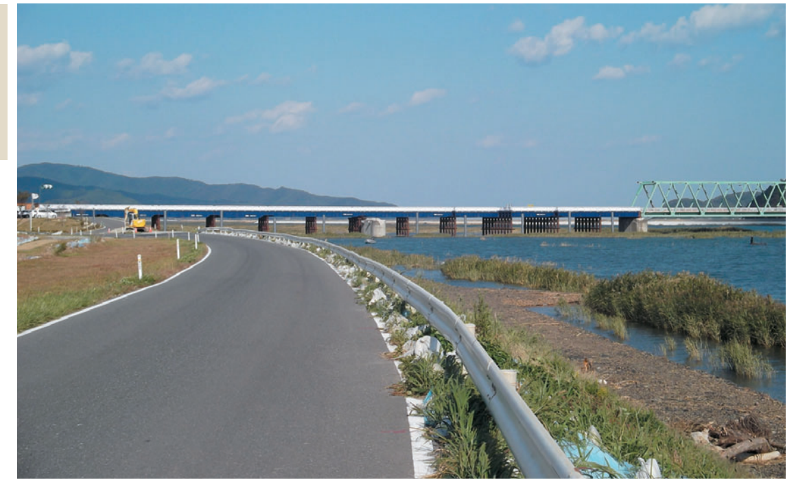
G栈橋工法にて下部工支持杭本数を削減手延にて架設
