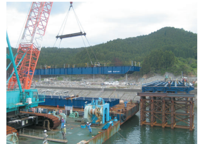
両側径間はクレーンにて架設 中央径間は台船クレーンにて一括架設 36mスパンをPGにて対応
