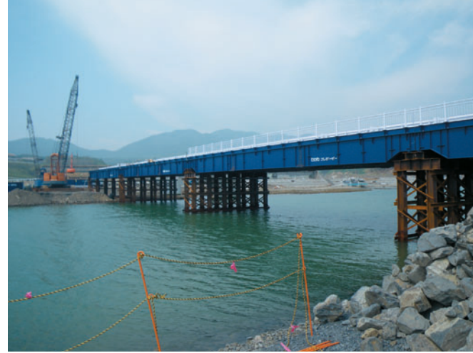
高水敷より下部工・上部工を手延架設工法にて架設
