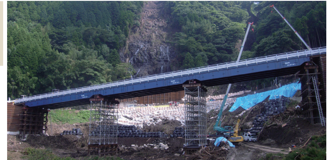
下部工はダウンザホール工法H鋼杭建込にて施工 中間橋脚部は、H鋼杭上にRoRo支柱設置
