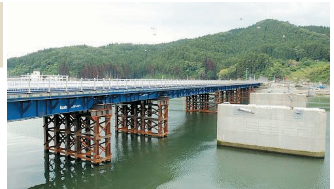
両側径間はクレーンにて架設 中央径間は台船クレーンにて一括架設 36mスパンをPGにて対応
