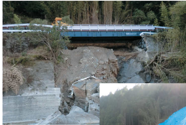
架設工法：手延架設工法 下部工ダウンザホール工法 工期：2011年8月25日～10月10日
