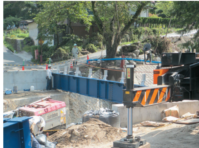
架設工法：25tラフター1台による施工
