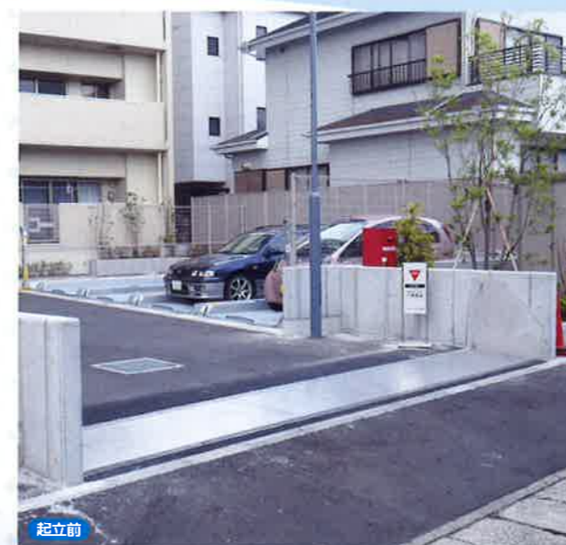
(静岡県沼津市)デュオ沼津ビューテラス 敷地出入口に設置 有効幅6.2m 有効高0.8m
