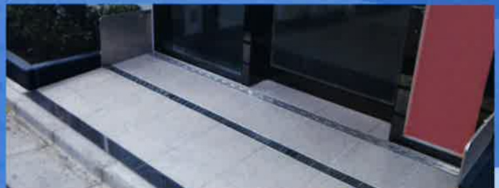
床板表面仕上げ例(タイル貼り)
